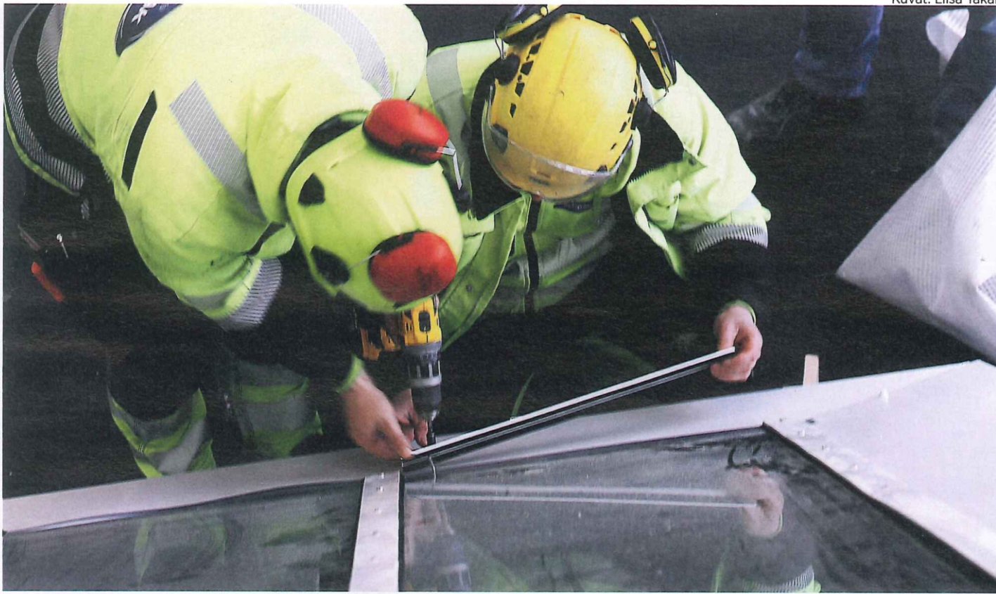
Alumiinilistaa kiinnittämässä asentajat Arturs Donis (vas.) ja Kaspars Guts.
